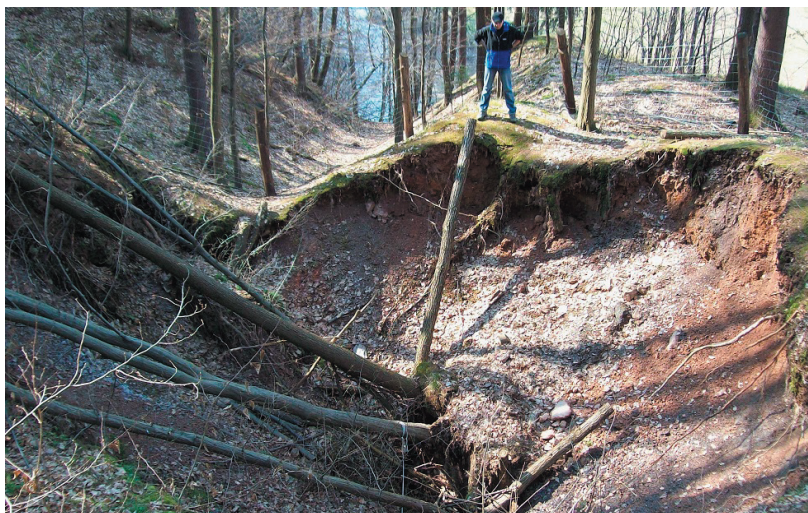
Ryc. 8. Zawał w miejscu szybu na przedłużeniu sztolni nad rzeką (fot. 04.2009 r.)
